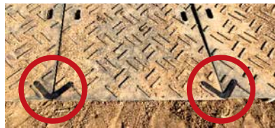
連結治具施工例
